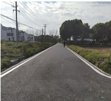
完成东勤村道路提升工程
