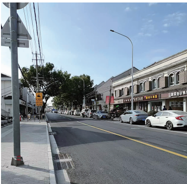
完成张泽路 (镇北路-卫星河桥) 道路中修工程
